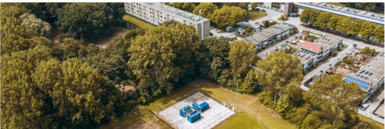
Abbildung 14: Wasserstoffnahwärme für Wohnhäuser in Rozenburg, Niederlande
